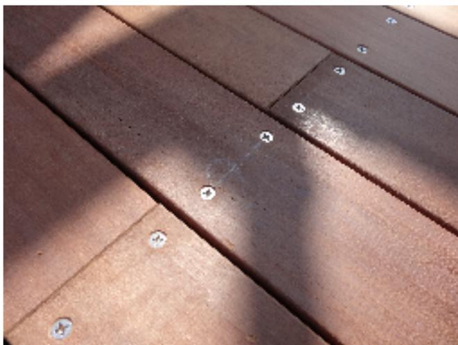
長さのジョイントを1か所にしないでフローリングのように交互にずらして施工
