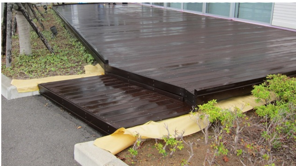
④ 出来上がり
